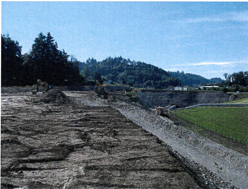
Abbildung 13: Die Vorbereitungsarbeiten für den Abbau der 2. Etappe sind am 12. Juni 2020 voll im Gang.
