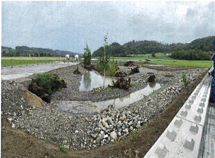
Abbildung 3: Der neue Biotop – Park kurz nach der Fertigstellung am 4. Mai 2020.
