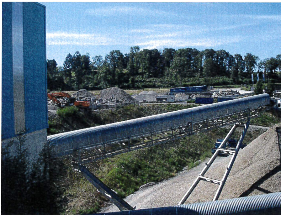
Abbildung 9: Blick vom Lagerplatz im nördlichen Teil der Grube gegen Osten in den Bereich des neuen Kies Lagerplatzes. Oben: Zustand im November 2008; unten: Zustand 12. Juni 2020. Die Rohbodenböschung ist fertiggestellt. Der ursprüngliche Fotostandort musste gegenüber 2008 um ca. 50 m nach Westen verschoben werden.
