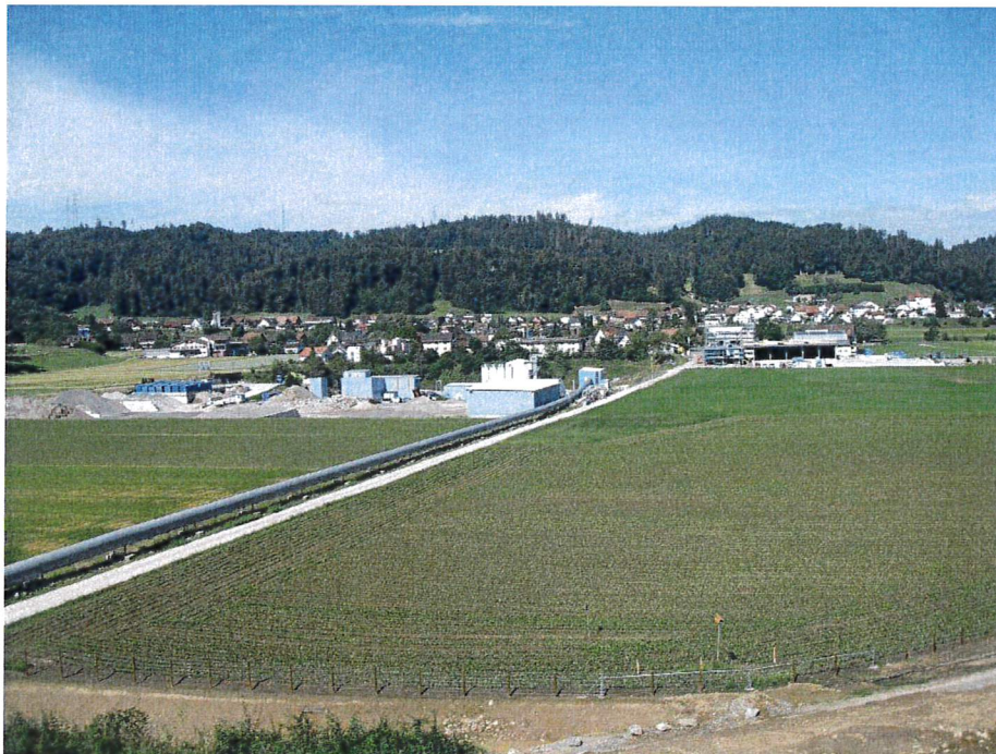
Abbildung 8: Ansicht des Kiesgrubenareals vom Stoltenrain aus, Blickrichtung SW. Oben: Juni 2007; unten 12. Juni 2020. In der Bildmitte: Förderband zum Transport des Abbaumaterials vom Stoltenrain. Das „alte“ Grubenareal dient als Kiesaufbereitungsanlage und Lagerplatz. Rechts im Hintergrund ist das neue Recycling / Betriebsgebäude zu erkennen..
