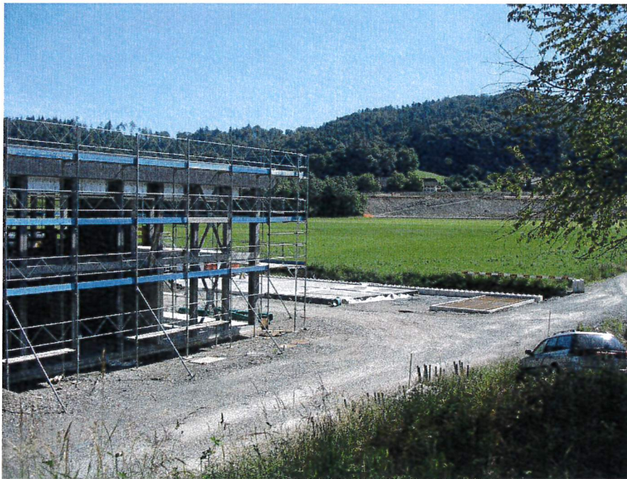
Abbildung 11: Blick vom Rand der ehemaligen Schafweide gegen Norden auf die Parzelle Nr. 942. Oben: Juni 2007; unten: 12. Juni 2020. Das neue Bürogebäude und die Recyclinganlage sind im Rohbau fertig erstellt.
