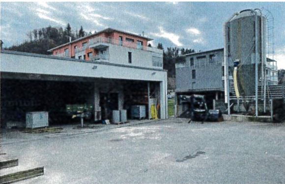
Abstellplatz, Einstellhalle, Salzsilo
